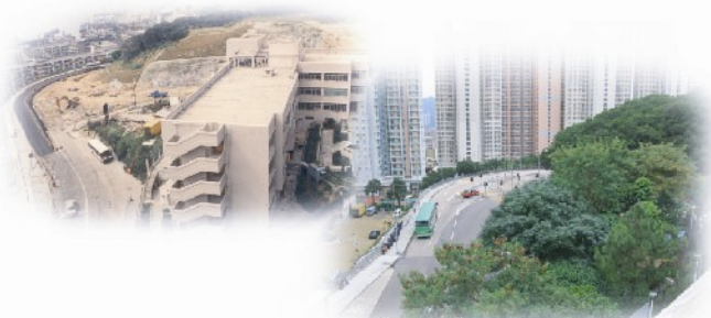
地貌：開闢碧雲道 Construction of Pik Wan Road
